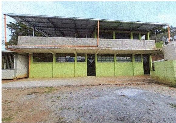
**Foto 3: Mejoramiento de estructura de tipo pórtico e instalación de lámina troquelada calibre 26.**
